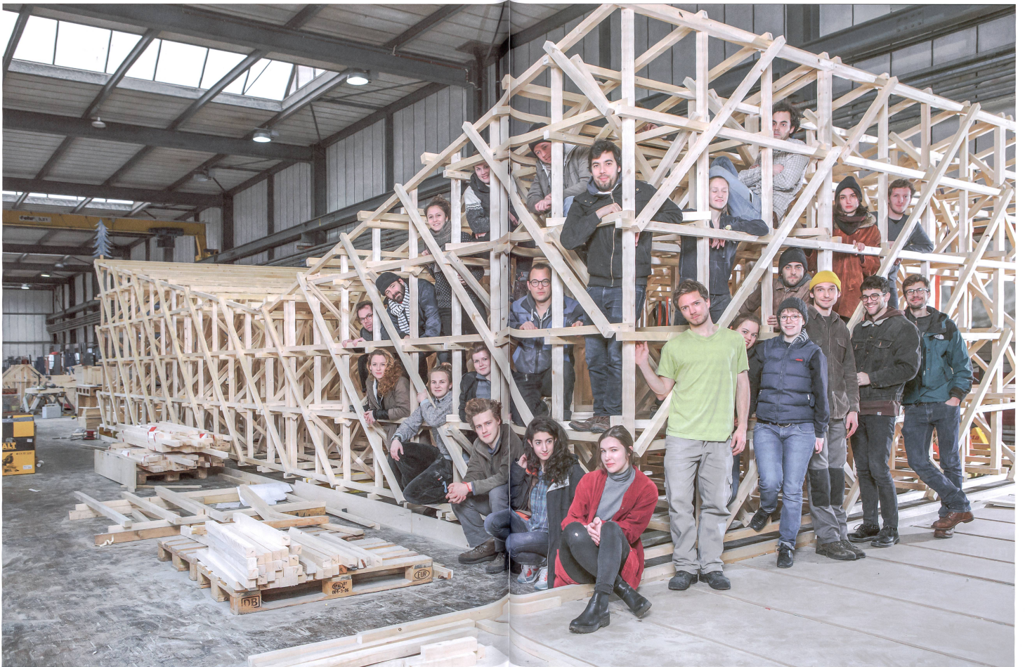
Ein Dachelement für den Manifesta-Pavillon wächst in Winterthur: ETH-Studierende von Tom Emerson entwerfen, planen und bauen die Holzkonstruktion selbst siehe Seite 24.
