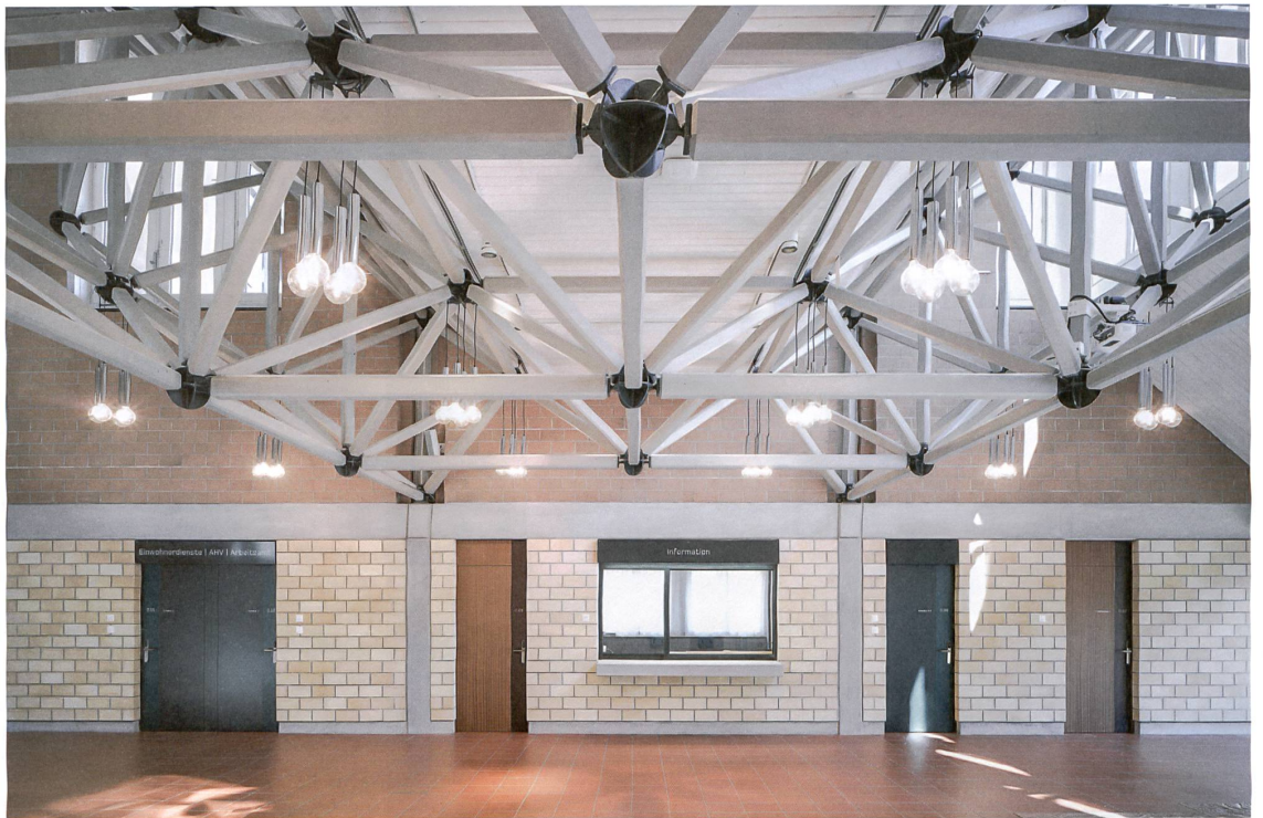
Im Einwohnersaal: Das Raumfachwerk, die Betonbalken und die roten Ziegel sind alt, die gelben Ziegel, die Türen und die Schalter sind neu.
