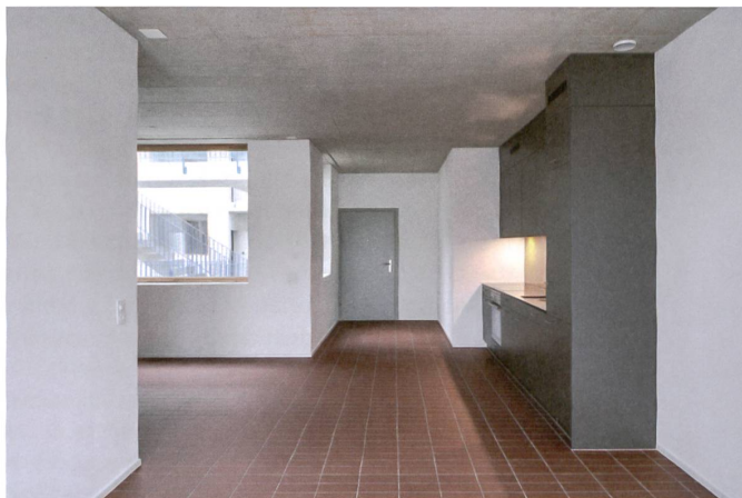
Einfache Materialisierung mit Plattenboden, Abrieb und Sichtbeton.
