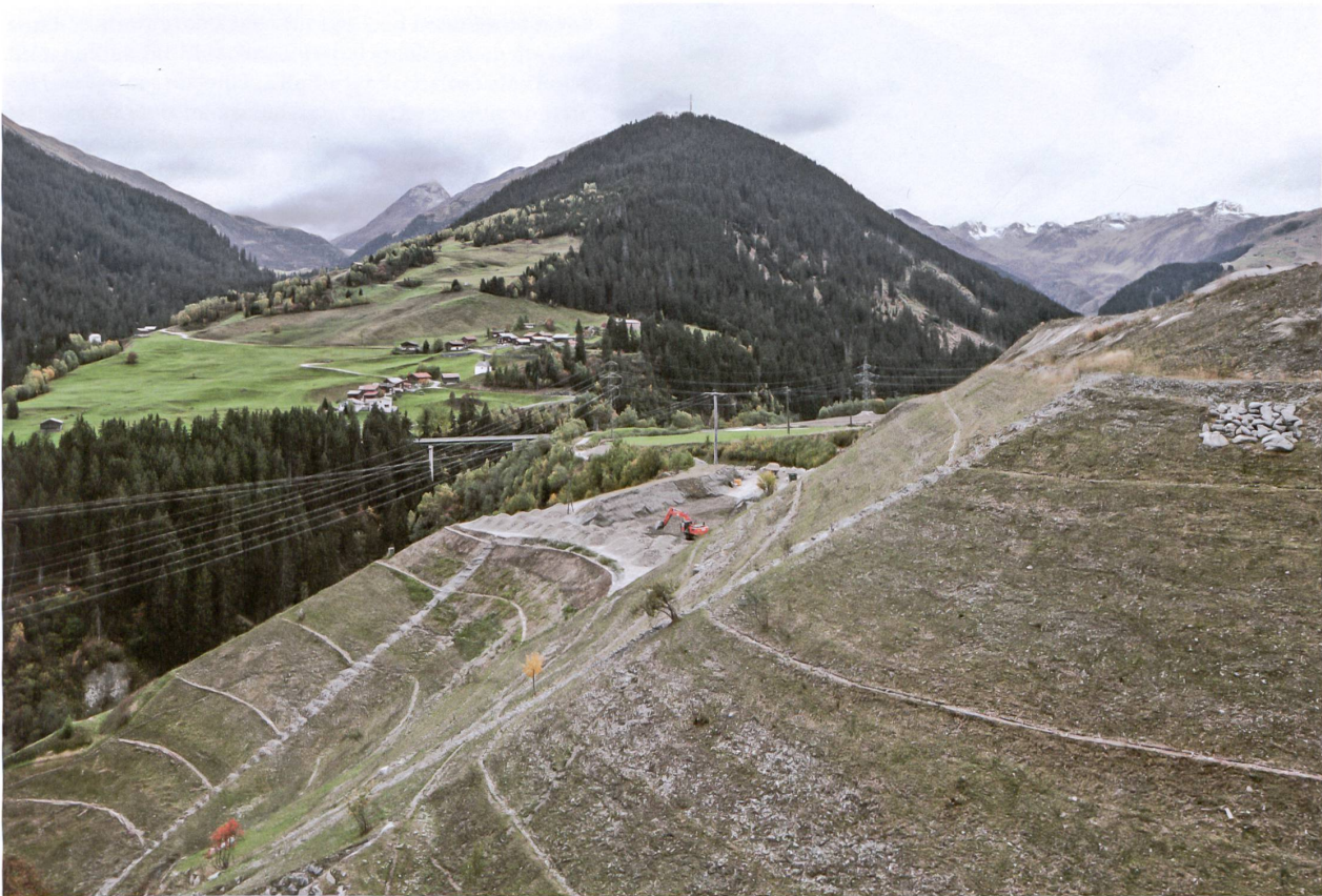
Die schroffen Flanken der Materialablagerung bei Sedrun machen die Künstlichkeit des Bergs lesbar.
