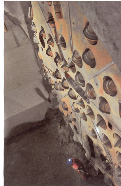
Tunnelbohrmaschine: 8 Meter Durchmesser, 160 Meter lang, 1500 Tonnen schwer.
