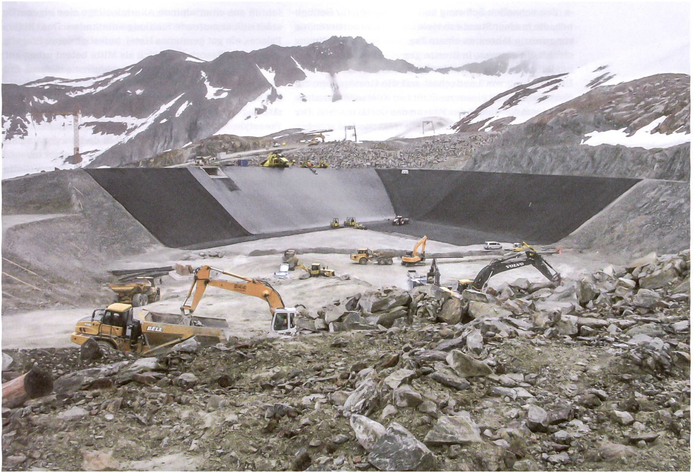
Schwerer Tiefbau für das Wasser der Schneekanonen: Bagger stellen im Sommer die Landschaften für die Fremdenindustrie von Sölden her. Foto: Lois Hechenblakner
