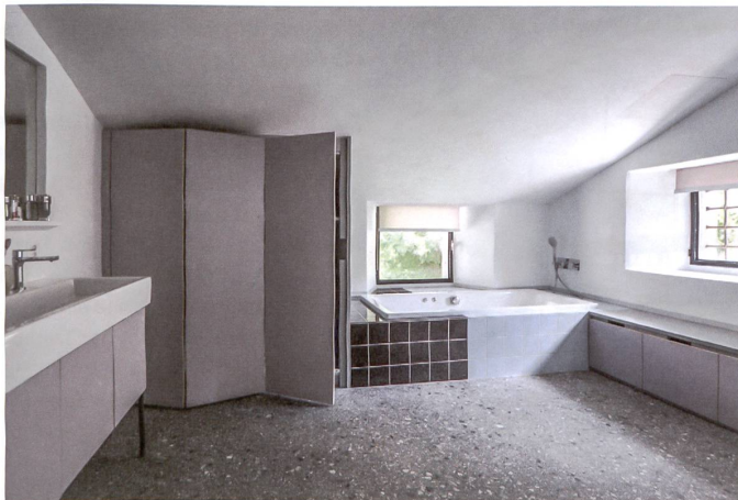
Im Bagno ist die Betondecke geschliffen wie ein Terrazzo. Foto: Alder Clavuot Nunzi
