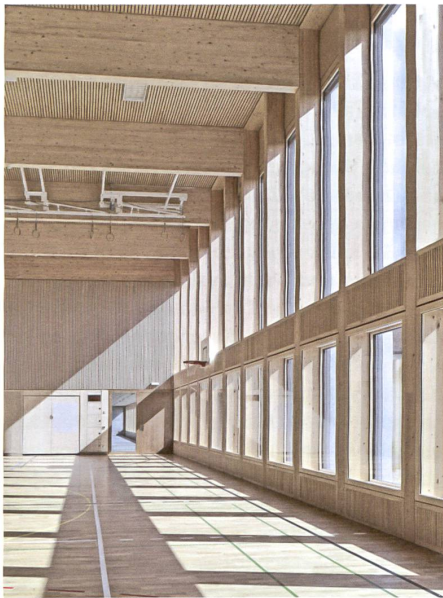
Die Turnhallenaufstockung in Holzelement-Bauweise. Fotos: Jürg Zimmermann
