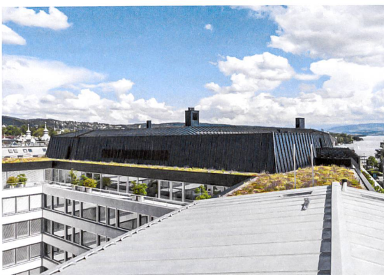
Das neue Dach: Ein Aufbau aus anodisiertem Aluminium umgibt den Lichthof, begrünte Schenkel die Tiefenhöfe.
