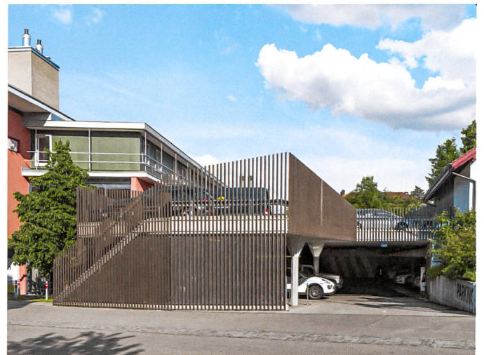
An der Spirgartenstrasse wirkt die Staketenkonstruktion je nach Blickwinkel offen oder geschlossen.
