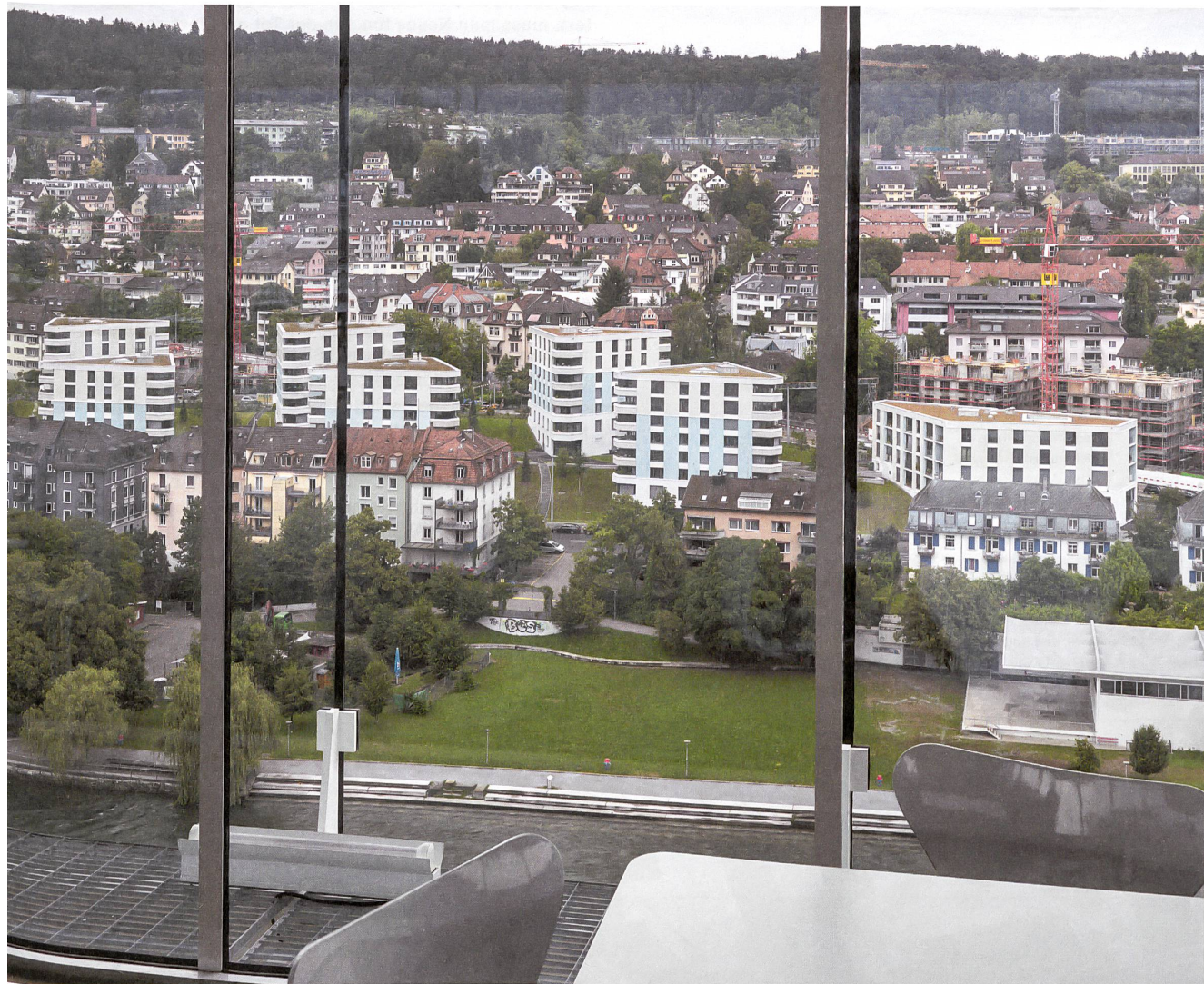
Blick über die Zürcher Limmat: Die dreieckigen Häuser entsprechen den Lärmschutzvorschriften und schaffen Durchblicke und Wege an der Hanglage.
