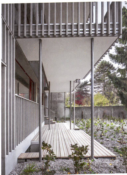
Der Gemeinschaftsraum auf der Gartenseite.
