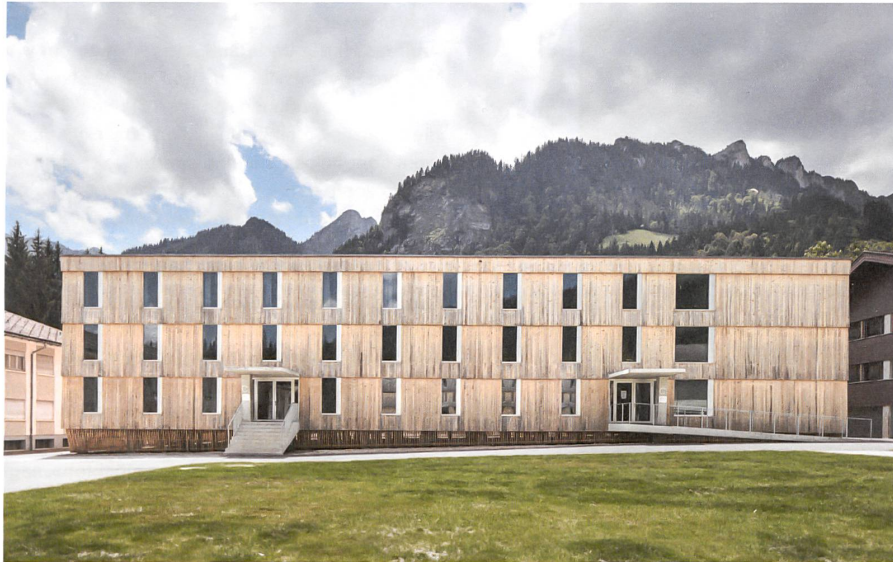
Auf Stützen und mit Weisstanne an den Fassaden: eines von zwei identischen Häusern auf dem Campus Schwarzsee.
