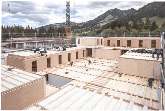
Der Totalunternehmer ist auch Holzbauer. Sein Elementbau punktet vor allem beim Transport.
