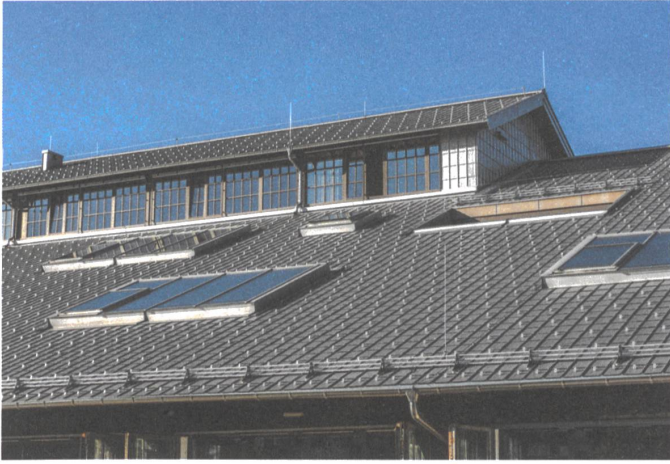
Auf dem komplett neuen Dach sitzt die aus Stahl konstruierte Dachlaterne.
