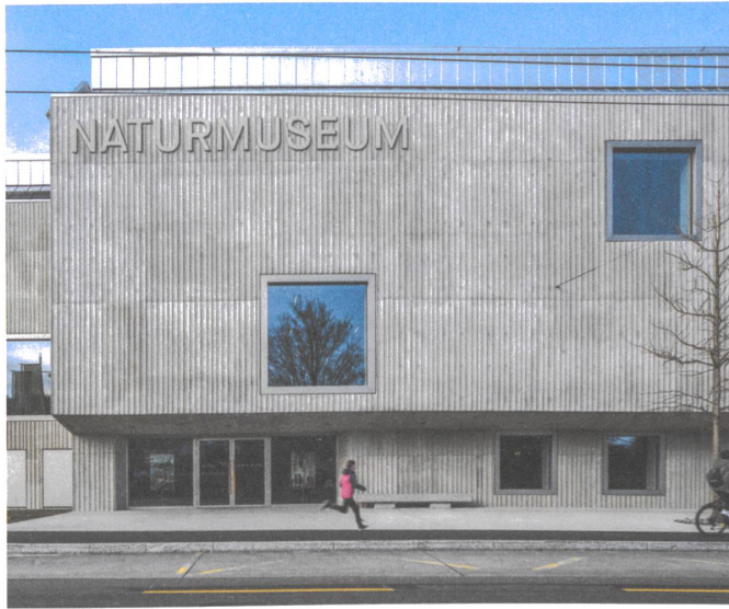
Naturmuseum St. Gallen: Ein chromstählernes Dach, ein nahtloses Betonkleid, quadratische Fenster – und ein allzu beiläufiger Eingang.
