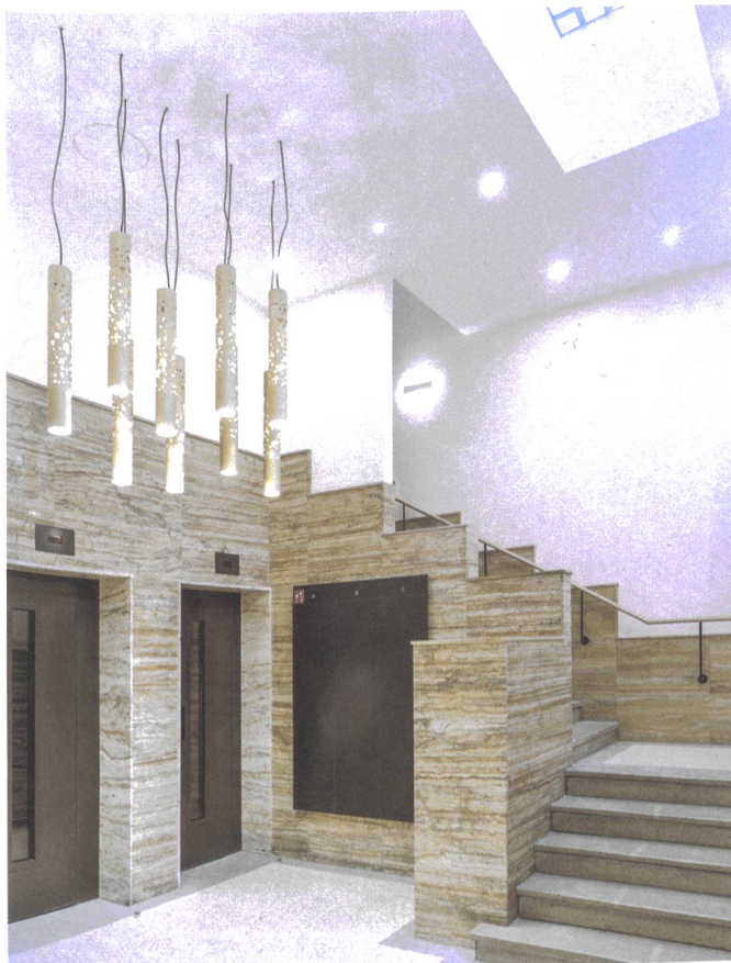
Die Travertinverkleidung der Eingangshalle blieb erhalten, die Beleuchtung ist neu.
