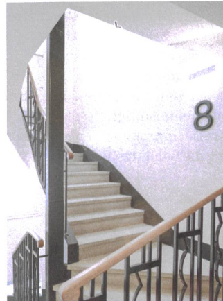
Das Geländer im Vordergrund ist nach altem Vorbild neu gearbeitet. In den 1970er-Jahren hatte man hier eine Wand eingezogen.
