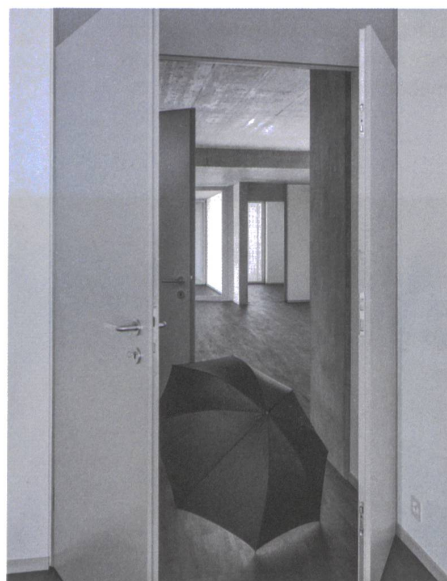
Pfeilerscheiben aus Beton verankern die Räume.
