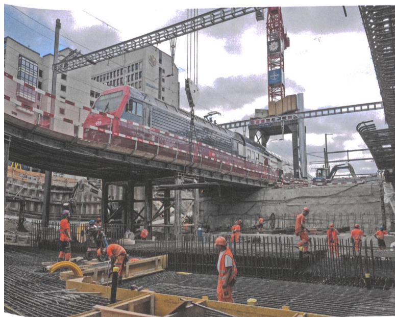
Bauphasen 4 und 5: Hilfsbrücken führen die Züge über die Baustelle für die Quartierverbindung und die Personenunterführung Mitte.
