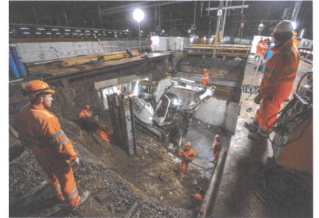
Bauphase 4: Endstation: Für den Bau der Personenunterführung Ost mussten die Gleise 1 und 2 an mehreren Wochenenden unterbrochen werden.
