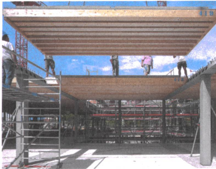
1 Millimeterngenau passt das Verbundelement in die Stützenriegelkonstruktion. | L'élément hybride s'inscrit au millimètre près dans la construction piliers-traverses
