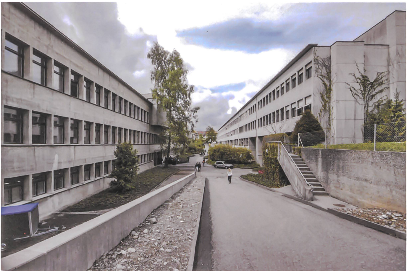
Der kompromisslose Betonbau von Otto Rudolf Salvisberg und Otto Brechbühl aus dem Jahr 1931 links und die feinsinnige Antwort von Andrea Roost von 1981, erweitert 2000.
