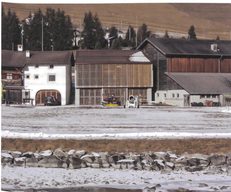
Zwischen Bauernhaus und Stall füllt die Remise die Siedlungslücke an Madulains Dorfrand.
