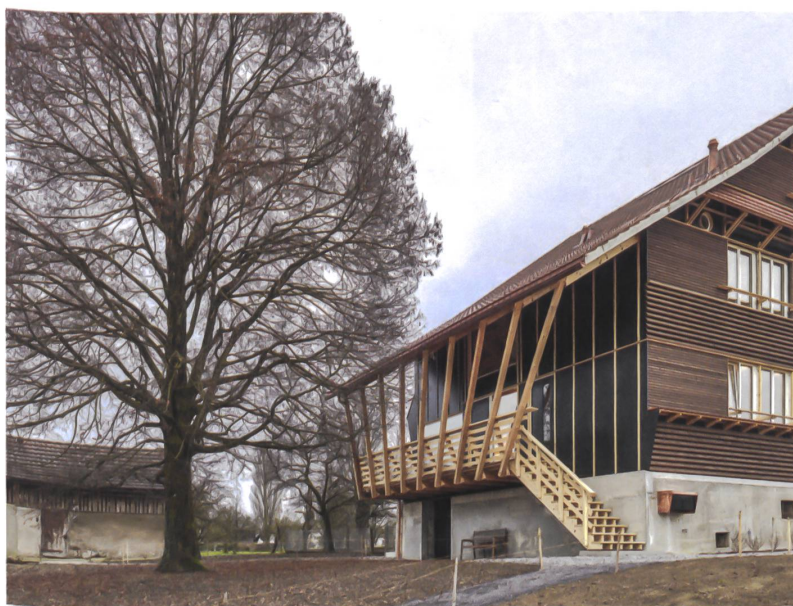
Beim Ersatzneubau in Cham dienen seitliche Lauben als Zugang – wie bei traditionellen Bauernhäusern.
