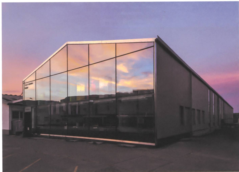
Von der Lagerhalle zur Möbelfabrik: Die Blechfassade wich einer Vollverglasung.
