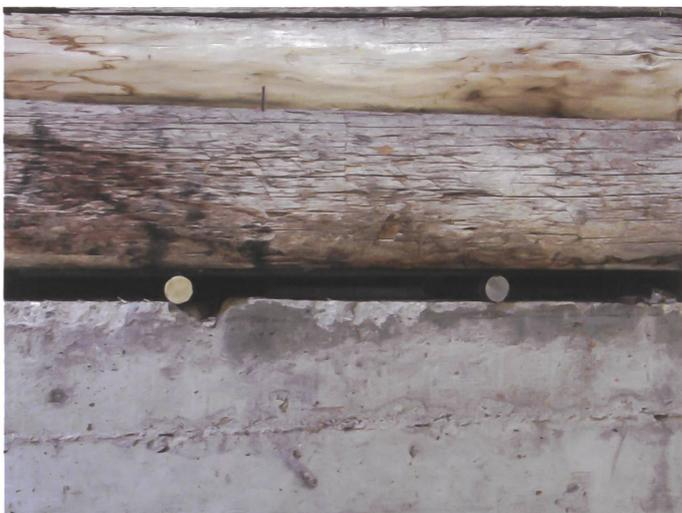
Zuerst schoben Bauarbeiter die hang-seitige Wand nach innen und sägten die überstehenden Balken ab. Dann gruben sie das Fundament an fünf Stellen ab und betonierten neue Punktauflager. Sie leg-ten Stahlrollen zwischen Holzbau und Betonlager, entfernten den Rest der Grund-mauern und rollten den Stall einen halben Meter zurück. Hydraulisch hoben sie den Strickbau an und rückten ihn in seine End-position. Dann gossen sie den Rest der Fundamente und untermauerten den Stall.
