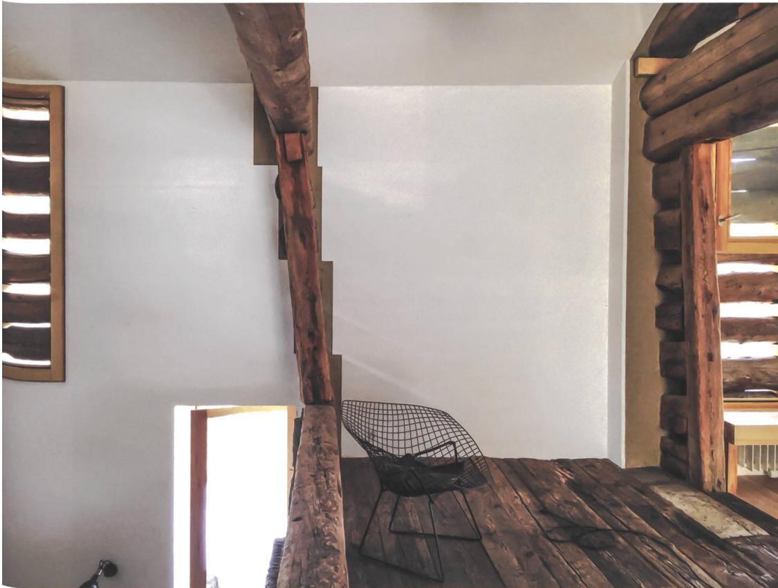
1-3 siehe Seite 22. Die Grobspanplatten sind nicht an den schiefen und unförmigen Strick angepasst, sondern versetzt gefügt. Der anfangs formbare Lehm ermöglicht die Abdichtung dank passgenauer Anschlüsse. Und die Konstruktion ist ablesbar. →
