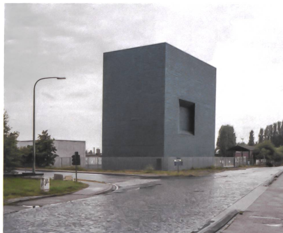
Trafostation (Petrol): Der 25 Meter hohe Monolith im Hafen von Antwerpen ist nach seiner Farbe benannt.
