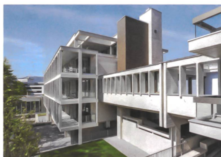
Gegen den Park erhielt das Haus eine Balkonschicht. Sie macht aus dem Büro- ein Wohnhaus.
