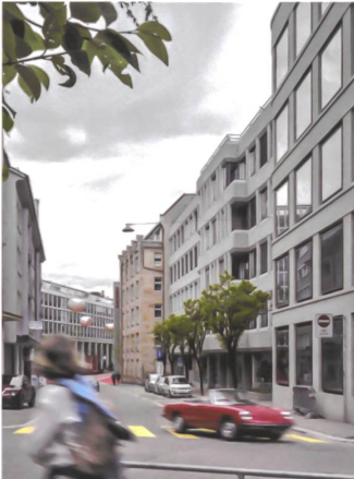
Die Fassade blieb unverändert bestehen, nur im Erdgeschoss ist sie neu.
