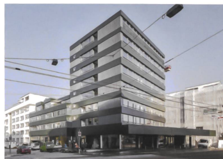
Das Blechkleid wechselt je nach Licht sein Gesicht. Das schräge Erdgeschoss bindet das Haus in die Stadt ein.
