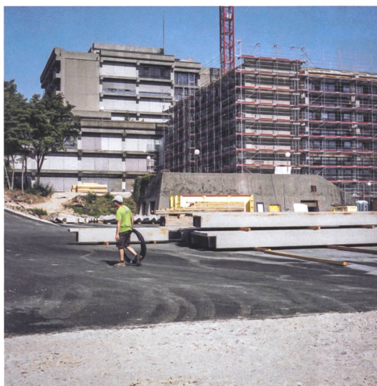
Auf dem Sportplatz sanieren Arbeiter die Betonelemente.
