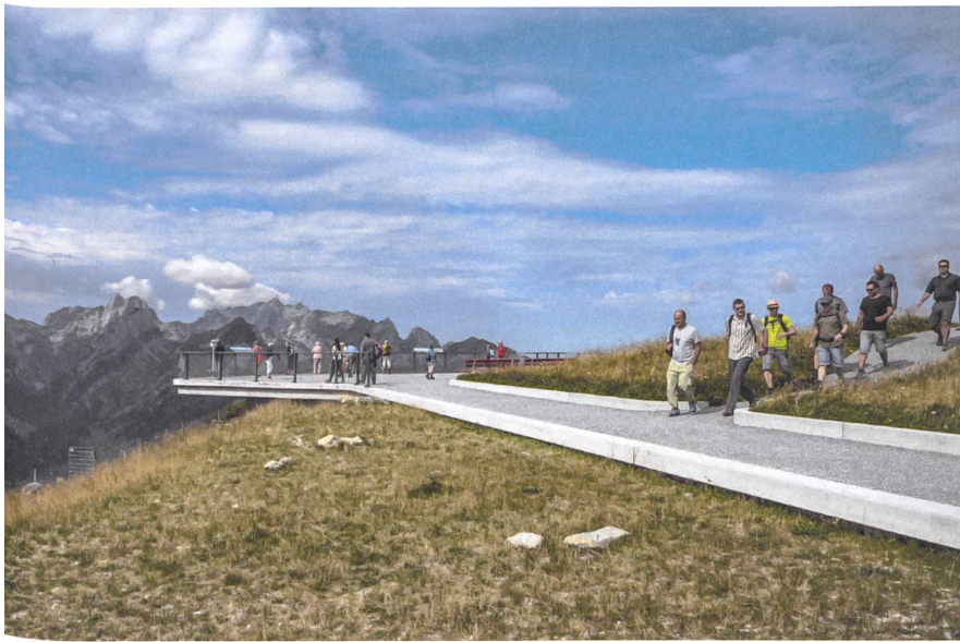
Der neue Kiesweg ist von einem Betonband eingefasst, talseitig kragt es leicht über das Terrain aus.
