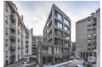
Mehrfamilienhaus rue Barton, Genf LRS architectes, Genf
