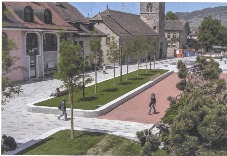
La création d'un parking souterrain a permis de transformer la place des Anciens-Fossés en zone piétonne.
