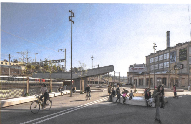
... und der Kesselhausplatz, sind belebte öffentliche Räume.
