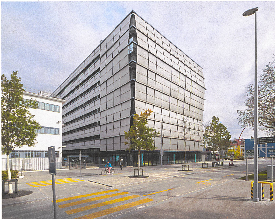
Mit dem Ausfahren des textilen Sonnenschutzes verwandelt sich nicht nur die Materialität des Laborgebäudes, sondern auch seine Gestalt.
