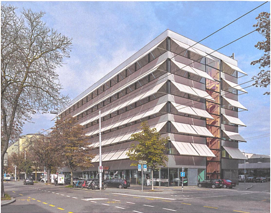
Das Acrylgewebe im gestalterischen Spiel mit der kristallinen Form des Gebäudes: so klar die Umrissse des Baus, so klar auch die textilen Flächen.
