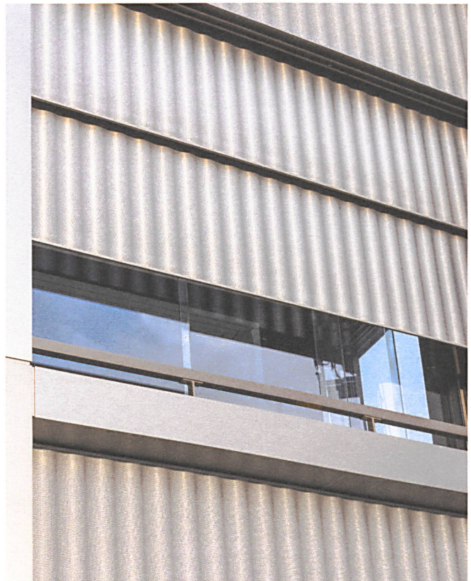
Die Sonnenstoren sind dreiteilig. | Les stores solaires sont en trois parties.
