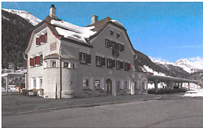
Burg bleibt Burg – der stolze Bahnhof von Zernez mit Bogenhalle und Umsteigeplatz auf die Busse nach Südtirol (rechts).
