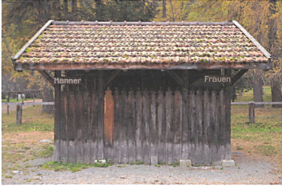
Auch das WC-Häuschen von Spinis wird restauriert und als Kleinod der Holzbaukunst der RhB-Pioniere erhalten. Foto: Max Galli
