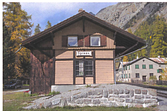
Die Station und das Ingenieurshaus (rechts) von Spinas werden renoviert. Foto: Max Galli
