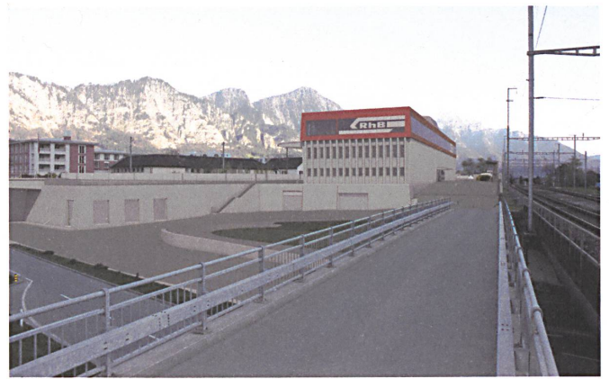
Beim Altersheim Neugut (im Hintergrund) entsteht der Interventionsstützpunkt mit roter Kappe. Visualisierungen: Maurusfrei Architekten
