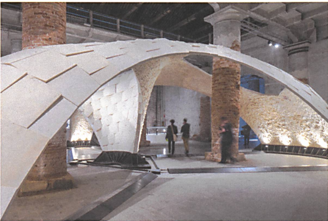
Eleganter als eine Eierschale: An der Architekturbiennale 2016 in Venedig schichteten Philippe Block und sein Team Kalksteinplatten zu einem Gewölbe, das ohne Zement und ohne Armierung 16 Meter überspannt. Fotos: Anna Maragkoudaki, Iwan Baan
