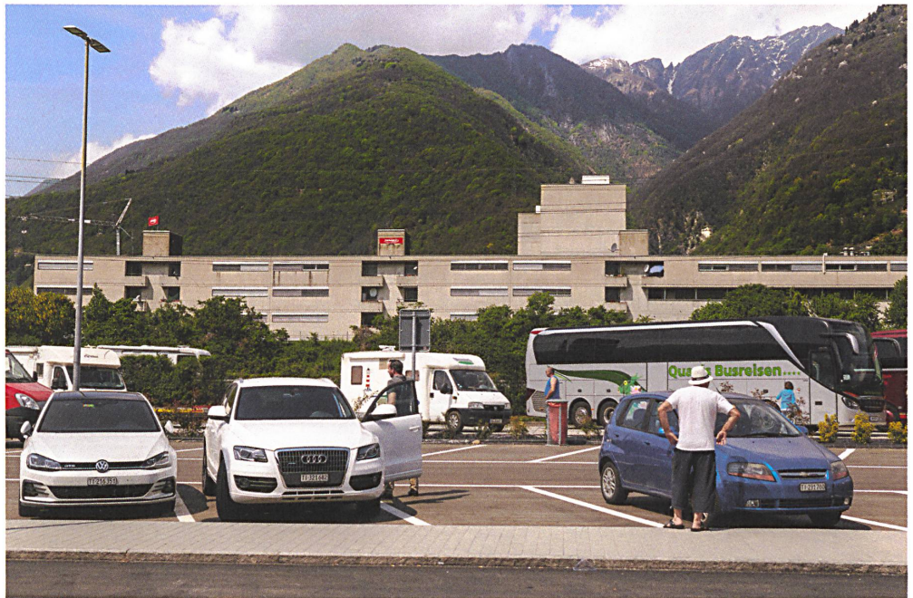
Der L-förmige Bau Morenal 1 steht mit seiner Längsseite parallel zur Autobahn und verdrängt sie aus dem Blick der meisten Bewohner.
