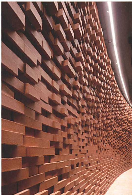
Durch die zufällig angeordneten Ziegel diffundiert der Klang.
