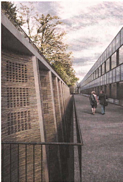
Beim ETH-Gebäude an der Gloriosastrasse in Zürich inszenieren Stützwände auch die Klimatechnik.
