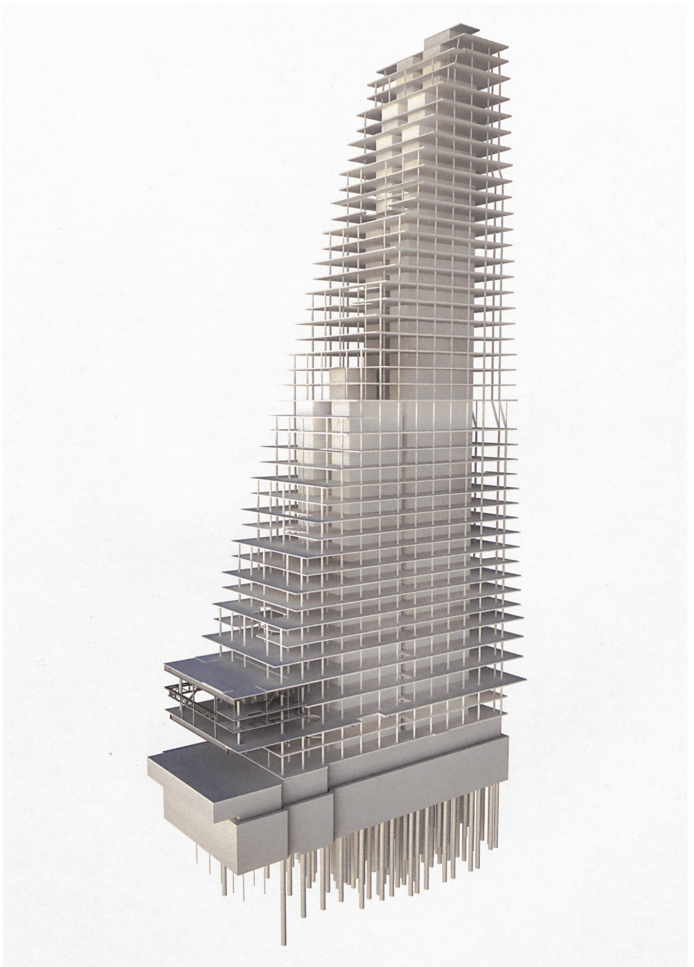
Die vier gekoppelten Betonkerne des Roche-Turms in Basel verhalten sich bei Windlasten steif und verformen sich erst bei starken Erdbeben. Visualisierung: Herzog & de Meuron
