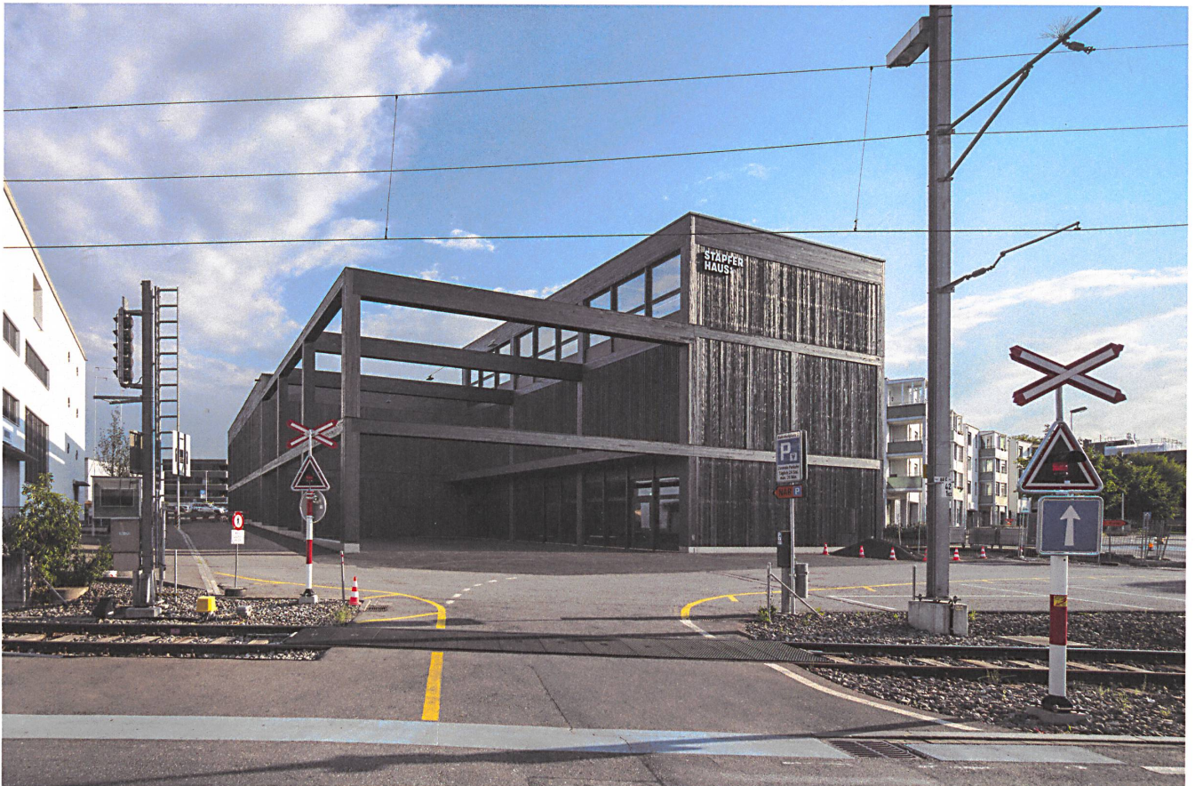
Kräftig, aber fein strukturiert: Das Stapferhaus ist ein Holzbau, durch und durch.
