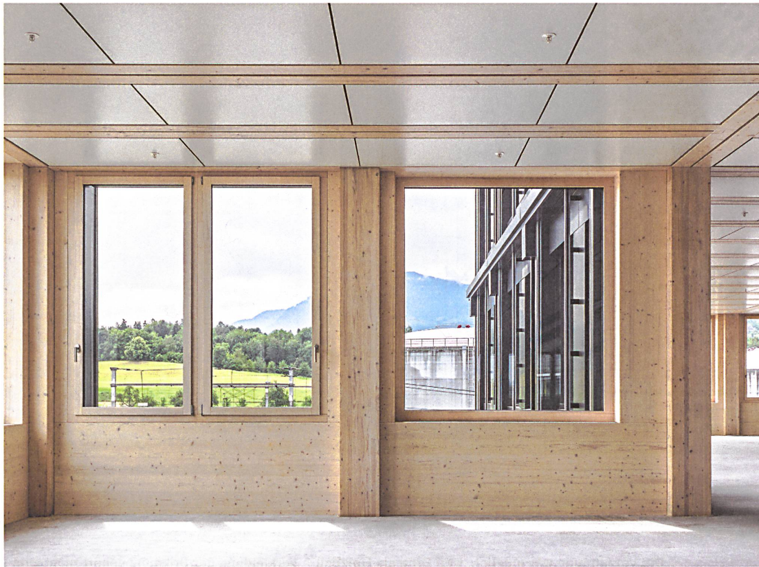
Dank der konsequenten Vorfabrikation sieht der Grundausbau im Bürogebäude in Risch-Rotkreuz aus, als wäre schon fertig gebaut. Fotos: Roger Frei
