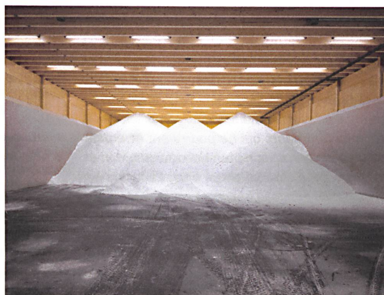
La halle de stockage du sel est accessible de plain-pied.
