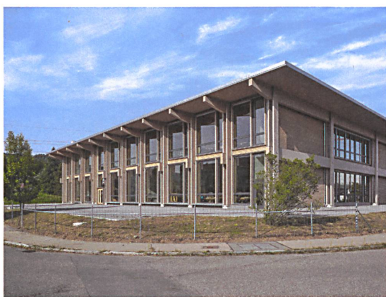
25 Im Ausbildungszentrum in Buchs werden Zimmerleute ausgebildet.
