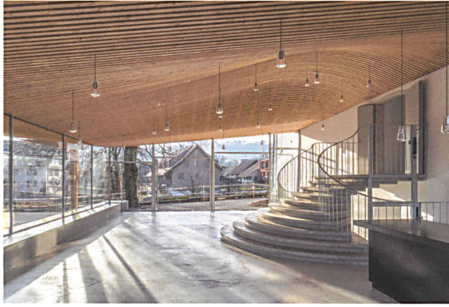
Schwungvoll verbindet das Projekt Treppe und Dach.
