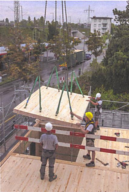
Bauarbeiter hieven das vorgefertigte Deckenelement an die richtige Stelle.
