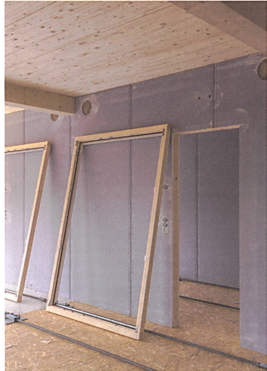
In den Bürogeschossen bleiben die Brettstapeldecken sichtbar.
