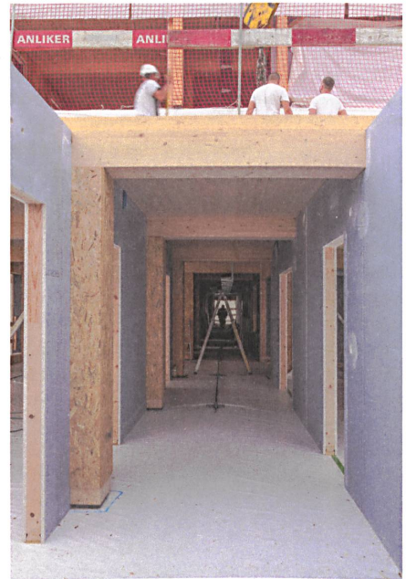
Blick in den künftigen Flur.
