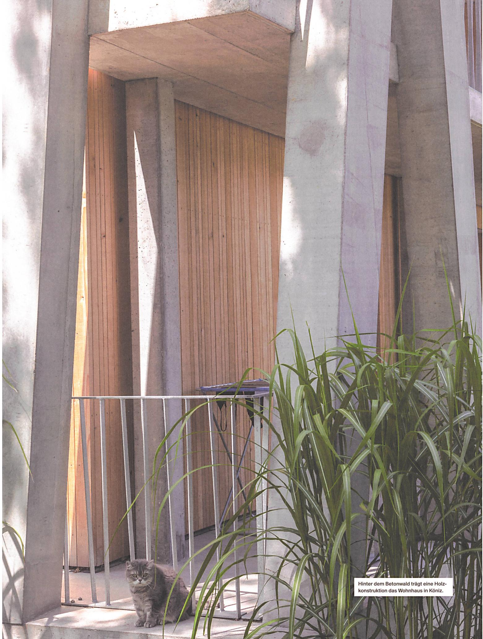
Hinter dem Betonwaid trägt eine Holzkonstruktion das Wohnhaus in Kőniz.
