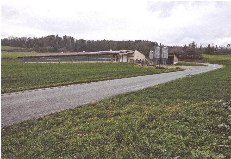
Eine Geflügelmasthalle bei Rottenschwil.
