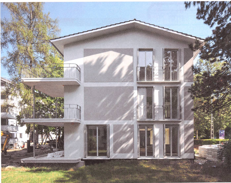
Der Neubau in Winterthur schliesst die Lücke an der Strasse.
