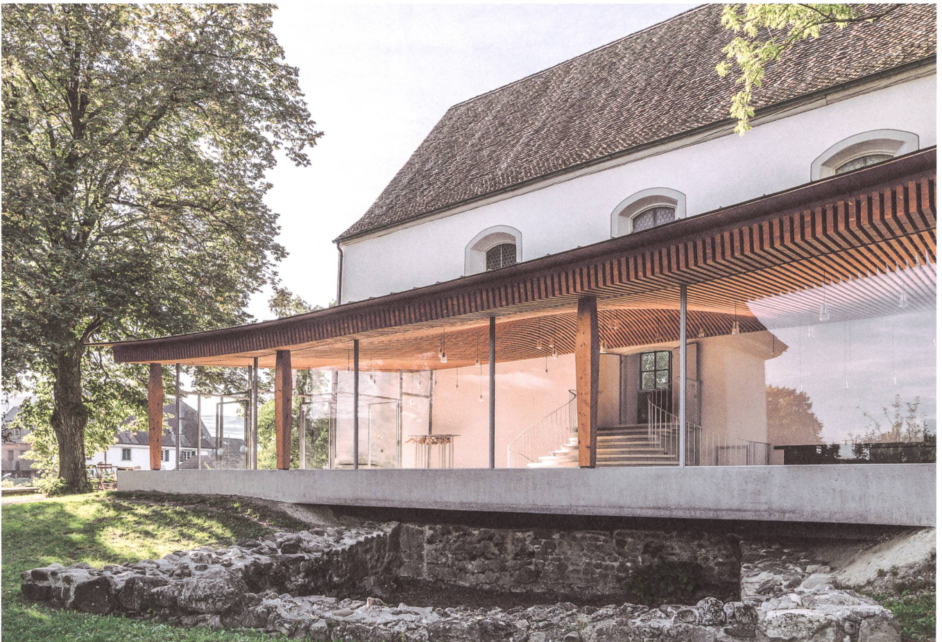
Konzertfoyer Boswil: Ein Betonbalken hebt die Eingangshalle über mittelalterliche Fundamentreste und dient zugleich als Sitzbank.
