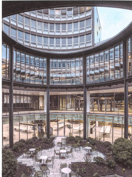
Das einstige glasüberdeckte Atrium ist zum offenen Innenhof geworden.
