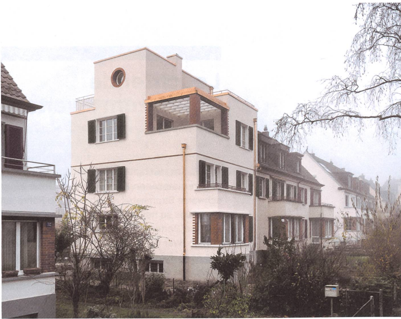
Eine Zürcher Siedlung aus den späten 1920er-Jahren mit aufgestocktem Kopfbau.
