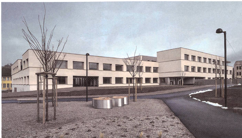
Die Gliederung bricht den grossen Massstab des Klinikneubaus in St. Urban.
