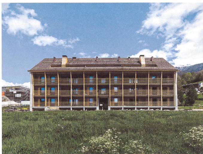
Walserhaus neu interpretiert: Mantelmauern aus Beton rahmen den Lärchenholzbau.
