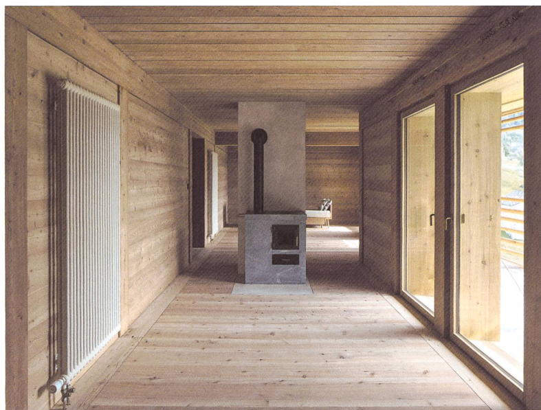
Noch mehr Holz: Daumendick bekleidet Lärchenholz sämtliche Böden, Decken und Wände.
